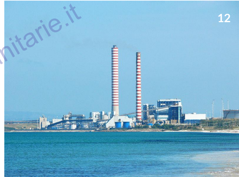
Centrale termoelettrica di Fiume Santo a Porto Torres.
