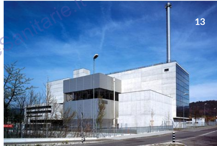
Termovalorizzatore di Thun Cantone di Berna
