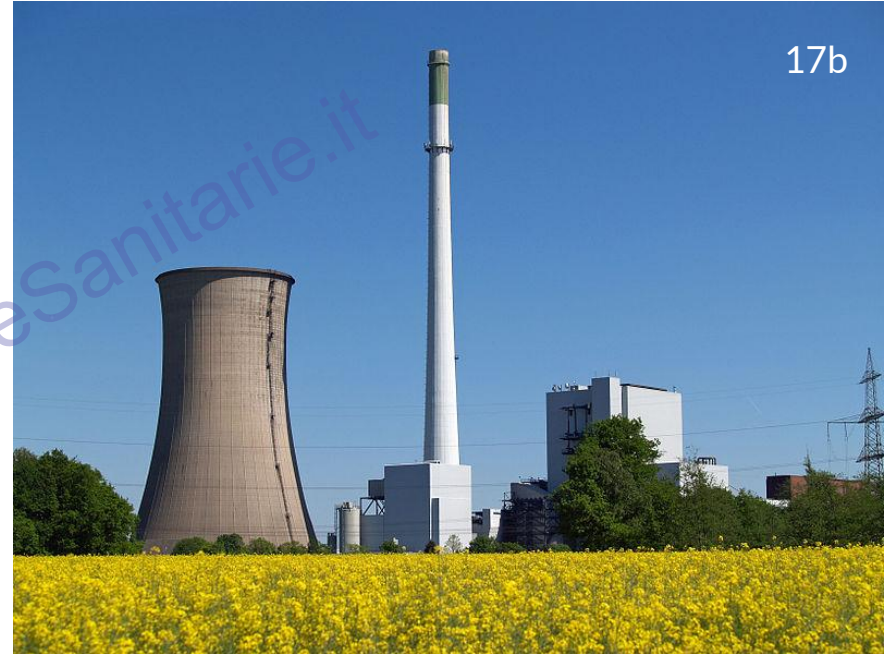
Torre di refrigerazione - Dortmund , Germany
