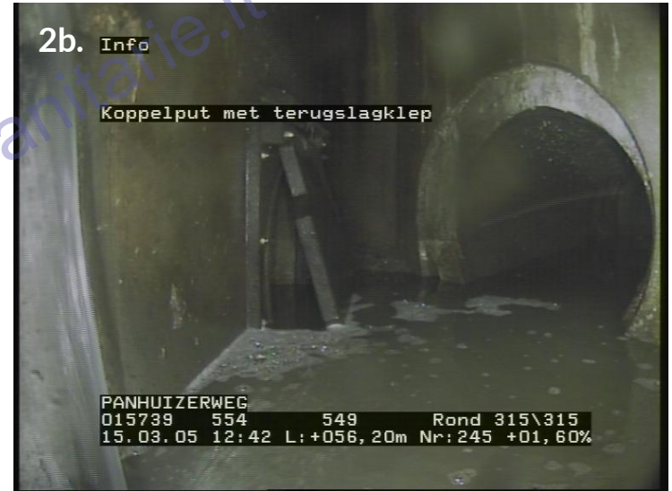
Immagine ripresa da un robot per ispezione fognaria
