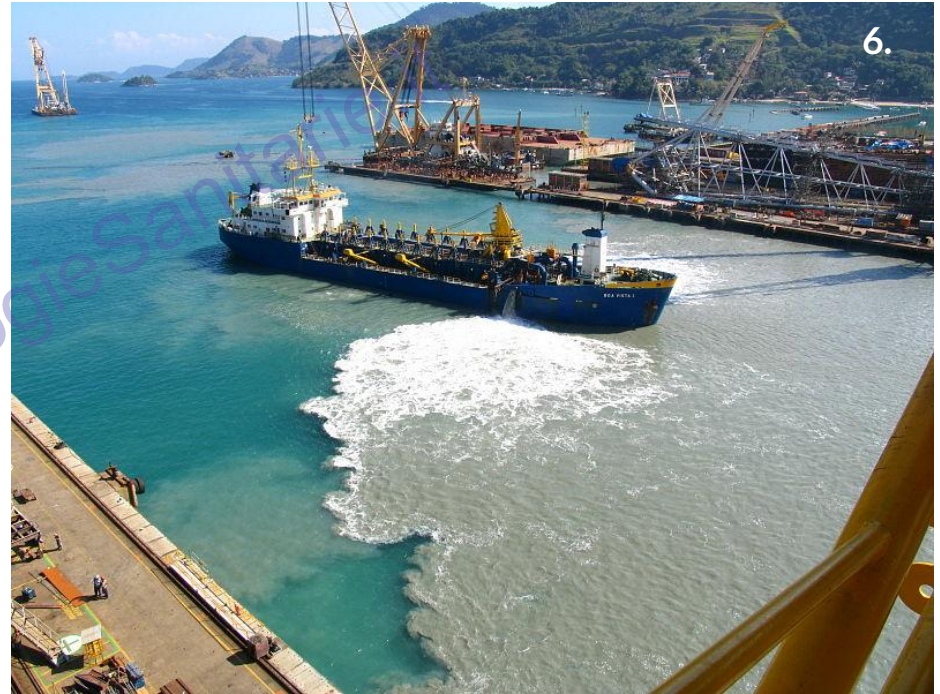
Esempio di inquinamento puntiforme. Cantiere a Rio de Janeiro - Brasile
